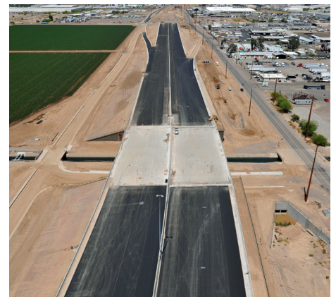
DESPUÉS: Mirando al norte hacia Lower Buckeye Road a la altura del canal Roosevelt Irrigation District (RID) en abril del 2019
