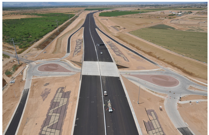
DESPUÉS: Mirando al noroeste hacia el intercambio de Estrella Drive en abril del 2019
